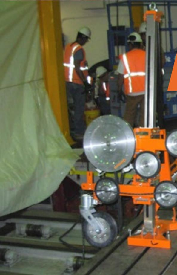
**Seilsägen von Beton mit starker Armierung, trennen von TRESOREN und STAHLPLATTFORMEN**
