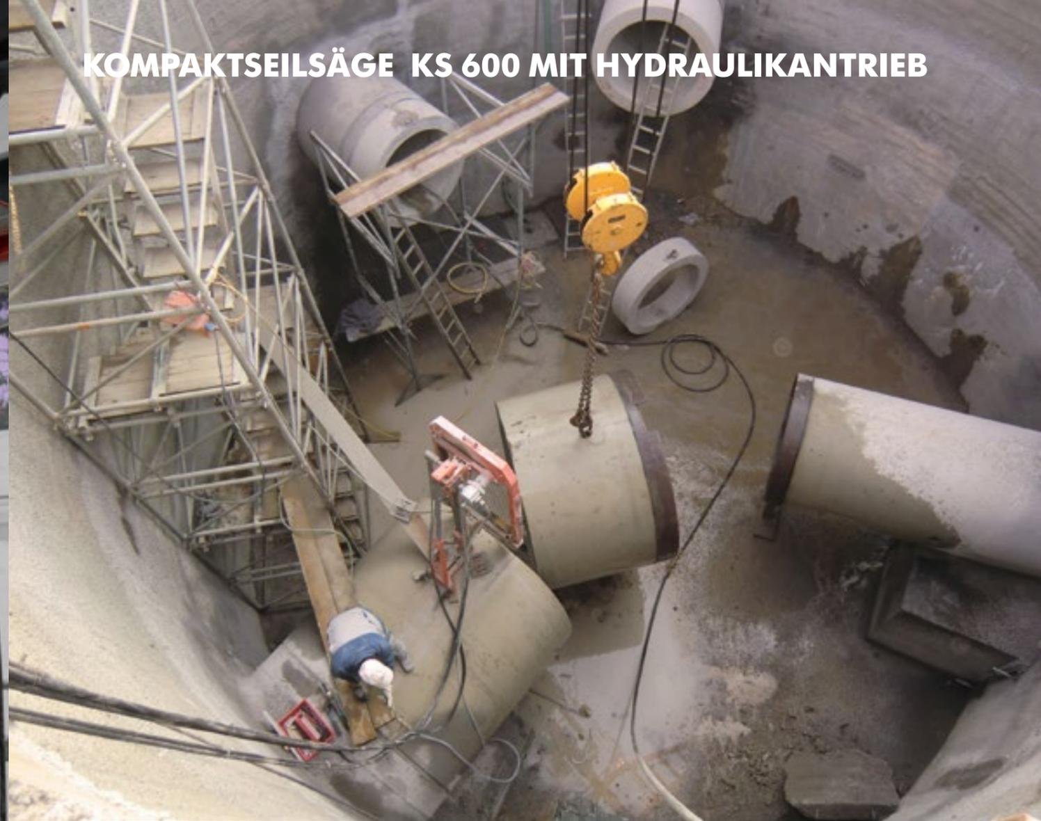
**KOMPAKTSEILSÄGE KS 600 MIT HYDRAULIKANTRIEB**
